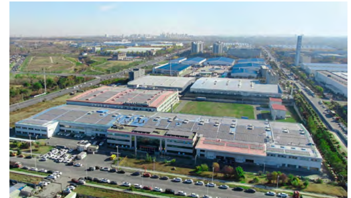
Auf den Dächern des chinesischen Produktionsstandorts in Changchun errichtete ElringKlinger eine Photovoltaikanlage, die jährlich rund 2.920.000 kWh Strom produziert.
